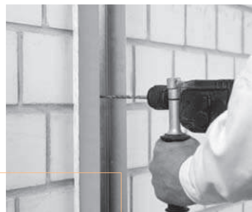
CW-profiilide kinnitamine müüritisel vahtplastiribadele
