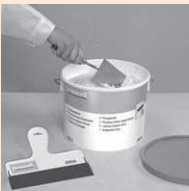
Täispinnaline pahtelduskiht FERMACELLI peenpahtliga ja FERMACELLI kipsipahtliga
