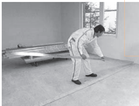
UW-ühendusprofiilide paigaldamine põrandal vahtplastile
