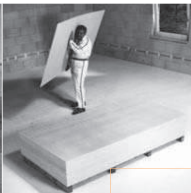
Kandke üksikuid FERMACELLI kipskiudplaat püstiselt
