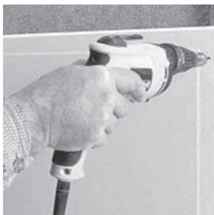
Terasest aluskonstruktsiooni külge kruvimine
