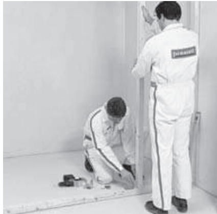
Puitkarkassi montaaž tihvtnaelte või terasnurgikutega
