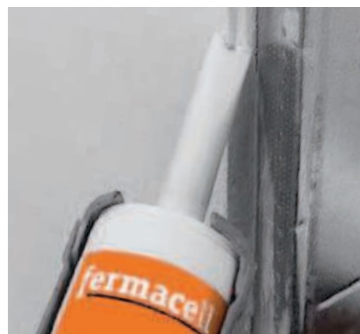
310 ml tuubi juhtimine piki plaadiserva. Spetsiaalne liimiprits doseerib 10 ja 12,5 mm plaatide jaoks täpse liimikoguse. 15 ja 18 mm plaatide puhul tuleb tippu teha sisselõige.
