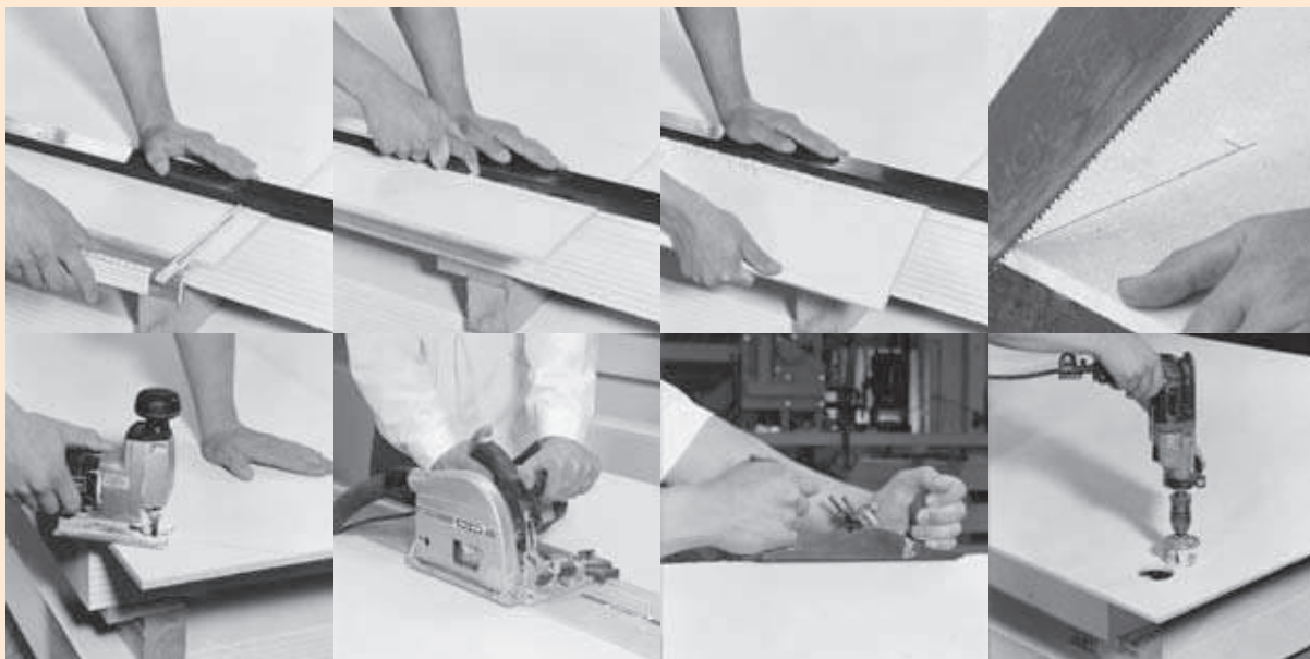
Saagimine elektrilise tikksaega
