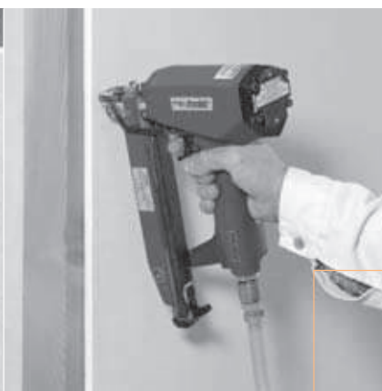
Puidust aluskonstruktsiooni külge klammerdamine
