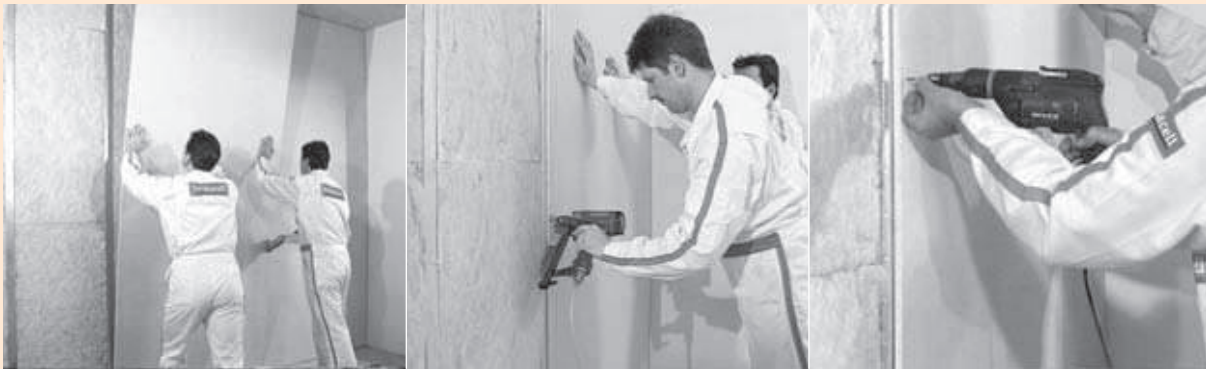
Metallist aluskonstruktsiooni katmine plaatvooderdisega
