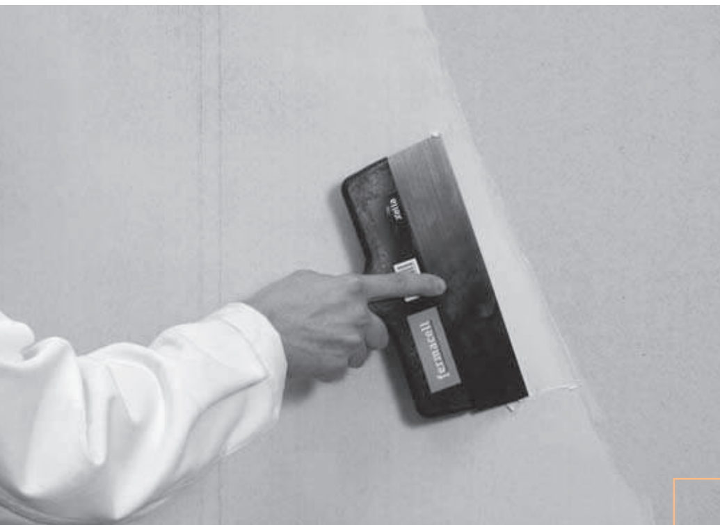
FERMACELLi kipskiudplaatide vuukimine
