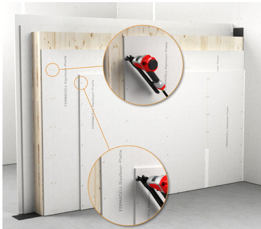
Kinnitamine plaat-plaadile
