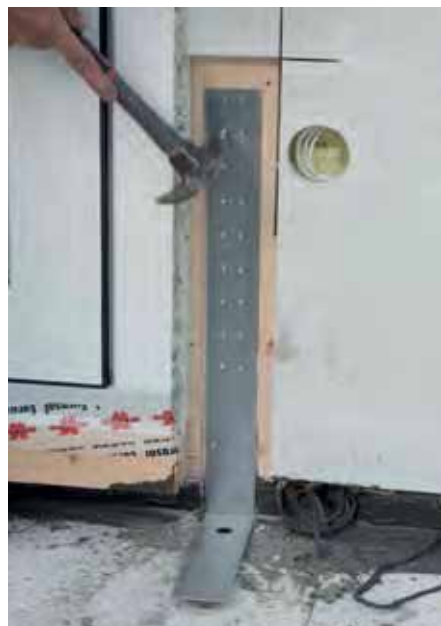
Ankru monteerimine (koormaplaati ei ole veel tüüblitega kinnitatud)
