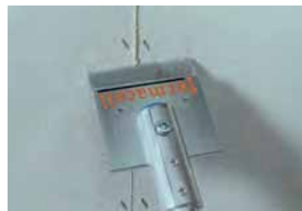
Üteligiise liimi eemaldamine fermacelli liimikaabitsaga
