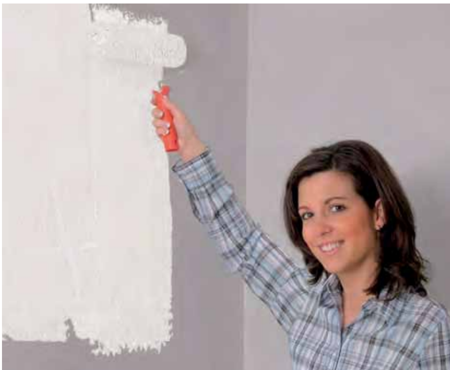
fermacelli rullkrohvii võib üle värvida dispersioon-, akrüül- ja silikoonvaikvärvidega.
