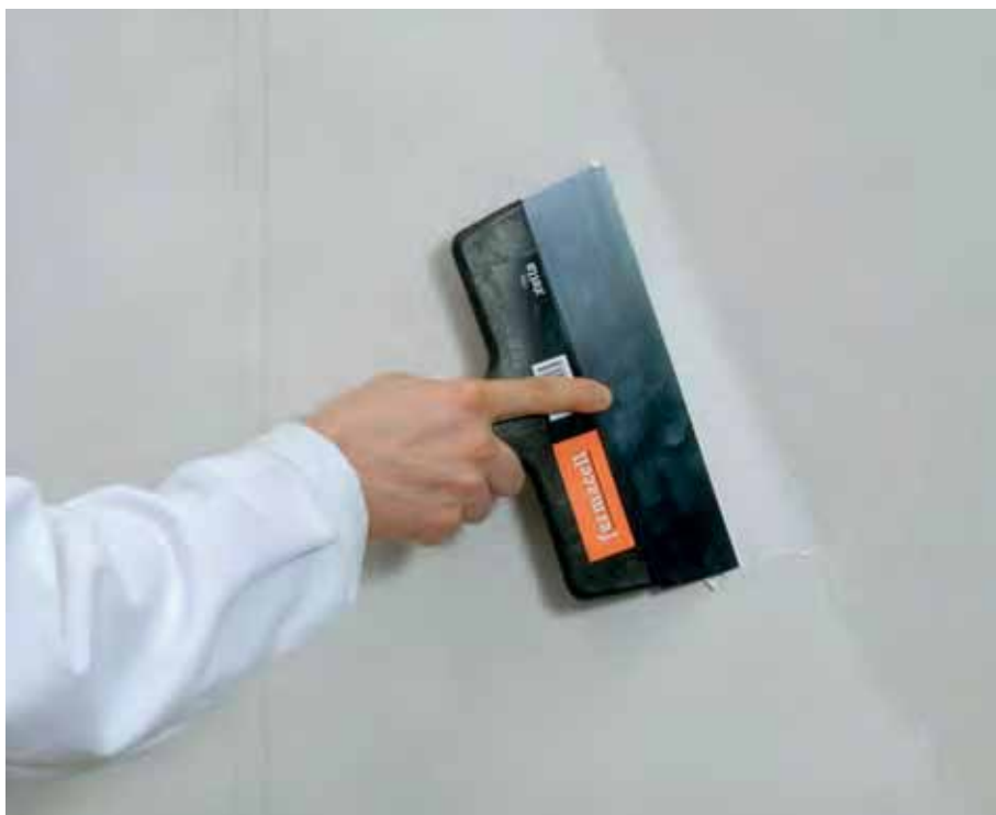
fermacelli kipskiudplaatide pindade pahteldamine
