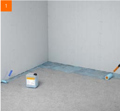
1 Kruentida aluspind fermacell™ süvakrundiga
