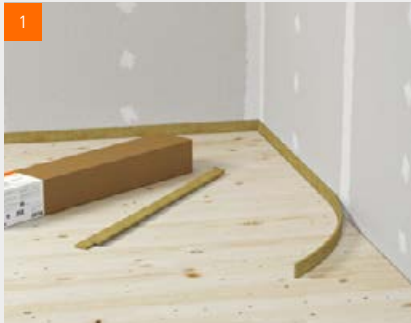
Servailintide paigaldamine ja nurkades otsakuti ühendamine
