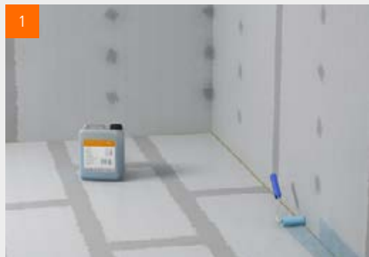
1 fermacell™ süvakruundi rulliga pealekandmine piirnevale seinapiirkonnale ...
