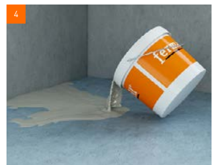
Valada põranda tasandussegu põrandale ja tasandada.
