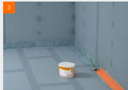
3 fermacell™ hüdroisolatsiooni pealekandmine nurkadesse
