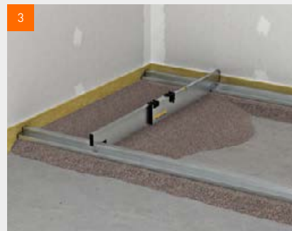
fermacell™ sideainega killustikpuiste tasandamine
