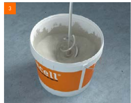
Segada sobiva seguriga aeglastel pööretel, kuni tekib ühtlane, tükikideta tasandussegu.
