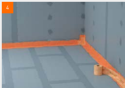
4 fermacell™ tihenduslinti kinnisurumine niiskesse hüdroisolatsiooni
