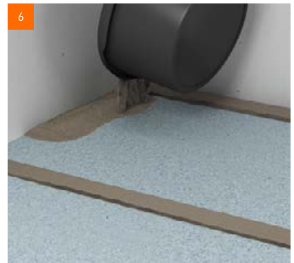
6 Seejärel paigaldada vallide vahele tasandupuistesegu T...
