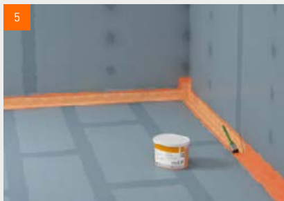
5 Tihenduslinti katmine fermacell™ hüdroisolatsiooniga kohe pärast kinnisurumist
