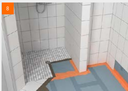
8 Powerpanel TE põrandatrapielementide korral tuleb liitekohtades kasutada hüdroisolatsioonisüsteemi
