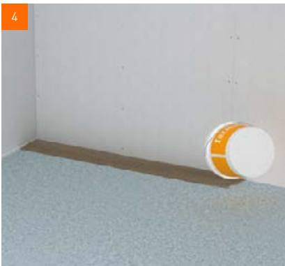
4 Kasutusvalmis tasandupuistesegu T on muld- niiske konsistents. Paigaldada esimene vall.
