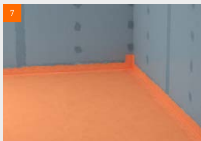
7 Kipskiudplaadist põranda kuivelementide kasutamise korral piirkonnas A0 tuleb kogu pind täiendavalt katta hüdroisolatsiooniga
