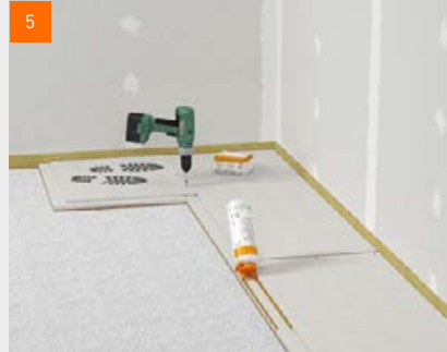
fermacell® põranda kuivelementide paigaldamine fermacell™ tasanduspuistele
