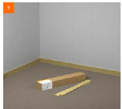
9 Vajaduse korral paigaldada servalindid.
