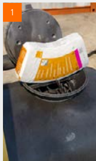
Segamisvahet: 8 kotti fermacell™ kärjepuistet + 1 ämber fermacell™ puistesideainet
