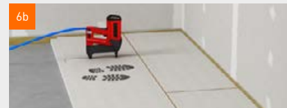
Kinnitamine kruvidega või spetsiaalsete klambritega 10 minuti jooksul
