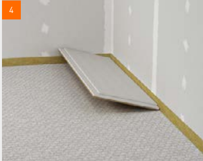
fermacell® Estrichelemente verlegen
